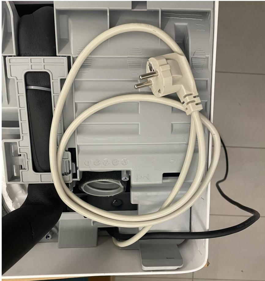
El cable de alimentación con enchufe y el cable de señal ya cableados, se deben a la imposibilidad de acceder al bloque de terminales interno, dada la presencia del ventilador del sistema Fresh Air (entrada de aire desde el exterior). Si es necesario, corte los dos cables, extendiéndolos a través de un bloque de terminales.
